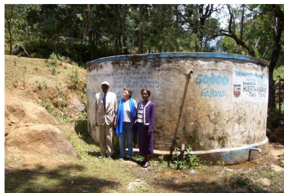
Der mit Mitteln der Stadt Hürth errichtete Wassertank in Kapropita
